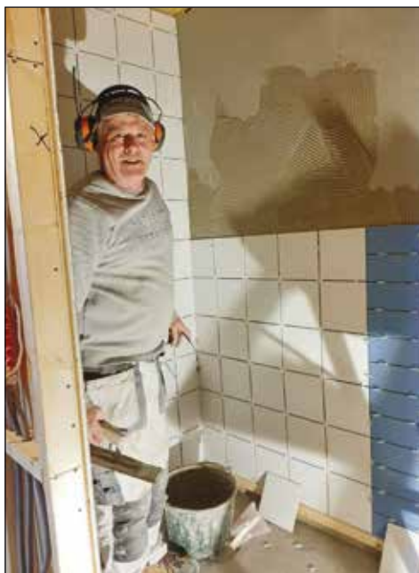
Helge legger fliser på det nye badet.
